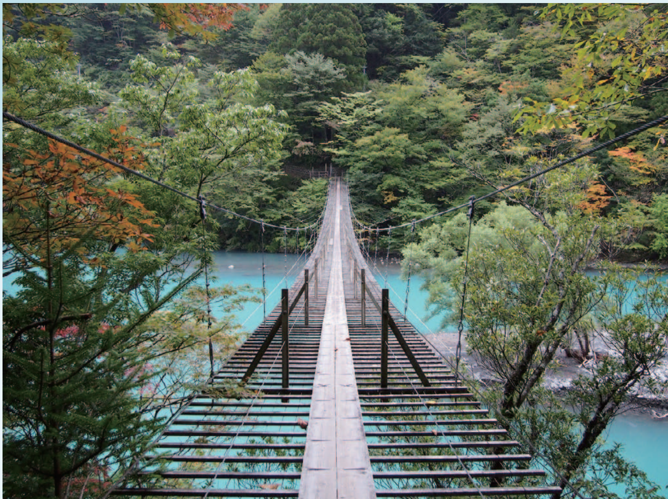
奥大井・寸又峡「夢の吊り橋」 撮影：情報サービス部長 西岡 良典
