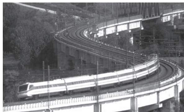
写真3. 高架区間を走行する列車
