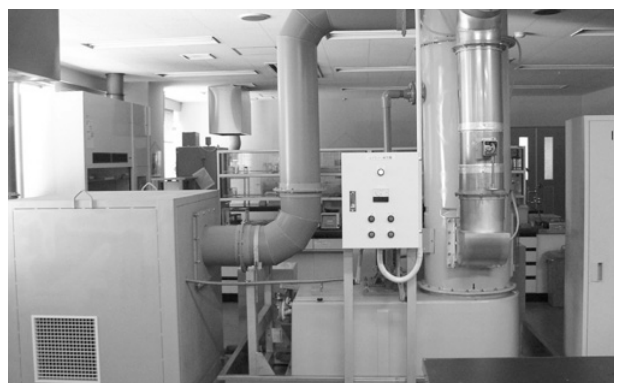
図4 新たに設置した排ガス処理装置
