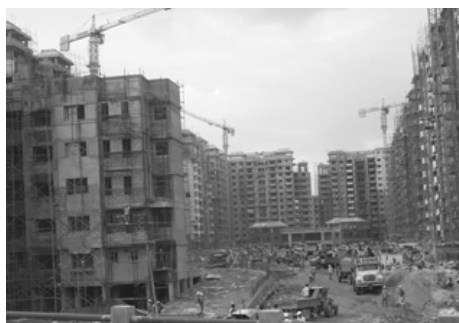
写真2 マンションの建設風景
