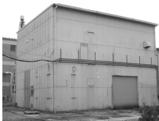
写真2 撤去・整備後
