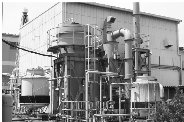
写真1 旧ゴム油化関連設備の撤去前
