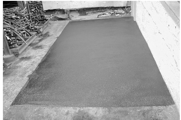
写真4 試験施工現場
