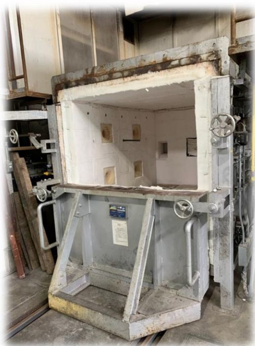
↑ 壁を外した状態
